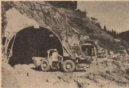
坑道の掘さくが開始された餌釣鉱山
