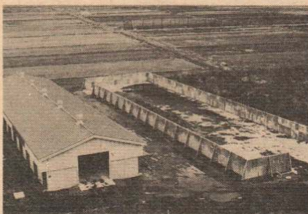
完成した堆肥施設、右が堆肥盤、左が堆肥舎
