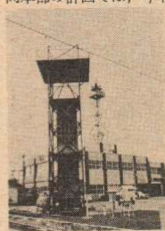
広域消防本部前に完成した「訓練塔」
