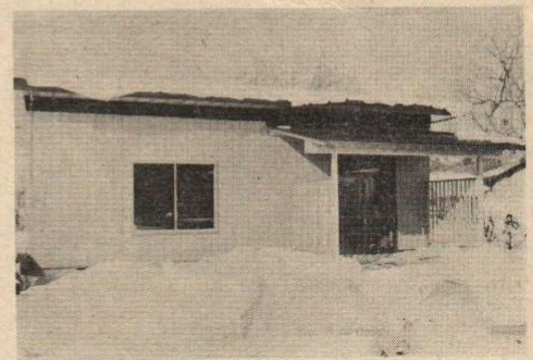
完成した赤石地区生活総合センター
