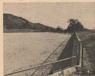
工事中の長根山球場
