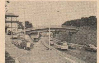
完成した太鼓橋
