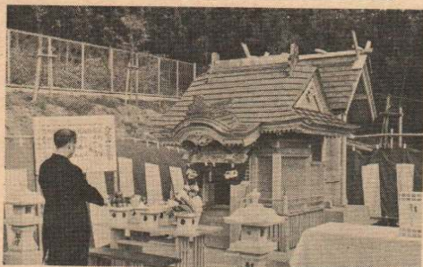
山館浄水場内に完成した水分神社鎮座祭
