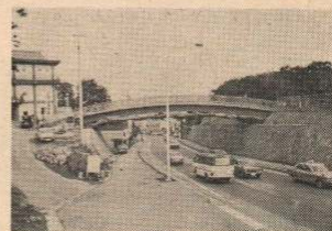
完成した太鼓橋
