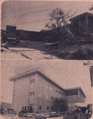
順調に工事が進む第一中(上)と成章中(下)
