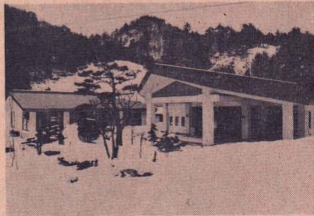
広域斎場全景
