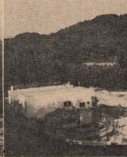
汚水処理施設
