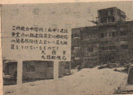
(写真) 工事中の南中学校
