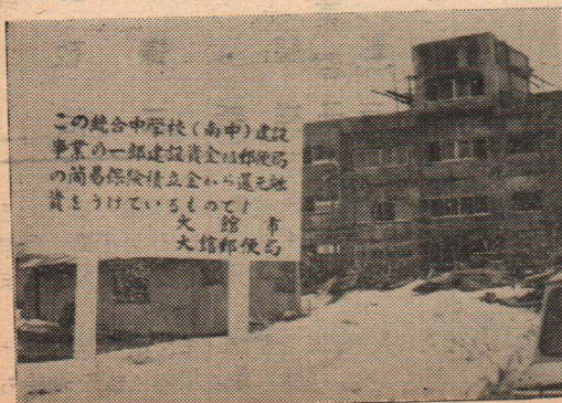
(写真) 工事中の南中学校
