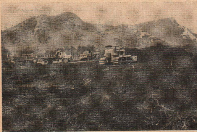
2. 宅地造成(餅田)工事
