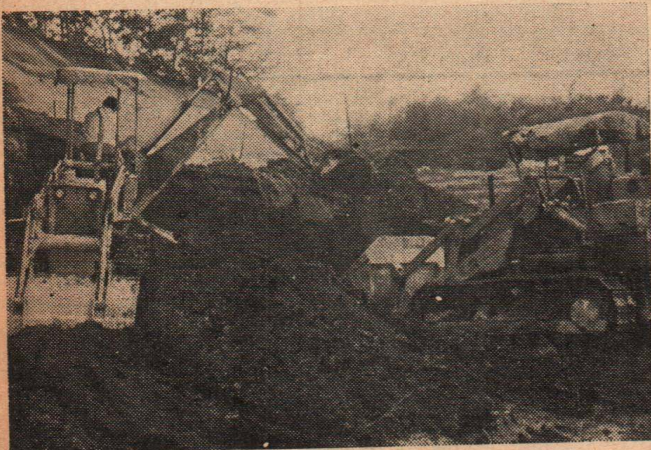
4. 狐台線市道新設工事
