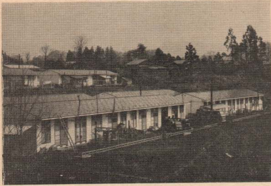
(大森野公営住宅)
