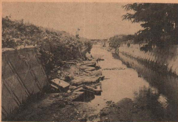
(写真) 8月の大雨でくずれた中山用水路
