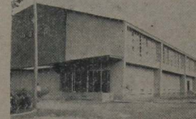
第一中学校校舎改築工事
