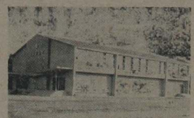
成童中学校校舎改築工事
