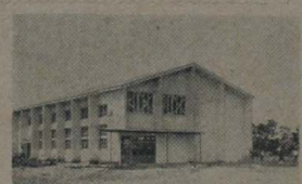
長木中学校屋体内体操場
