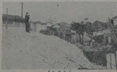
大工町の区画整理工事の様子
