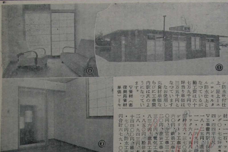
写真説明 1、モデル住宅全景 2、寝室 3、居間兼台所(玄関口)
