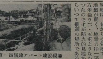
写真・四階建アパート建設現場
