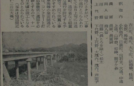
二井田大橋の建設状況
