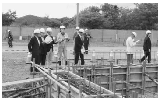
現地調査の様子 (ハチ公の駅(仮称)建設予定地)
