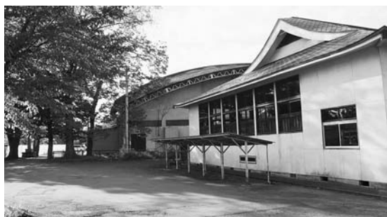
本庁舎の建設に伴い解体される予定の武道館と市民体育館
