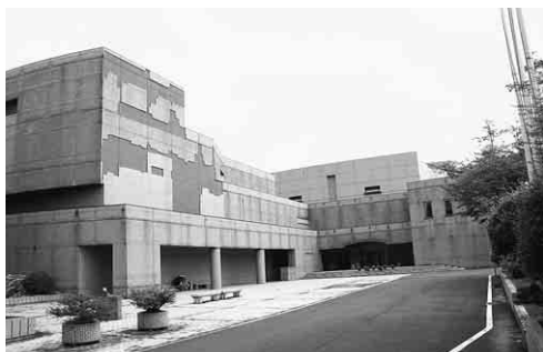
市民文化会館は今年度から2カ年で外壁の改修工事が行われる
