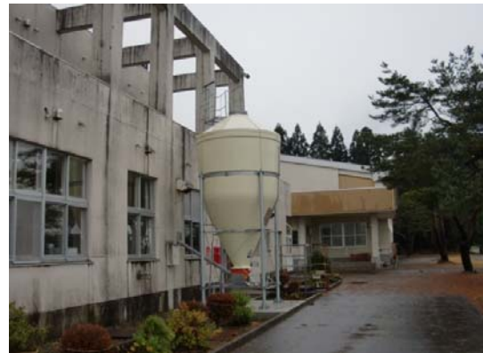
・ペレット貯蔵施設(燃料タンク)
