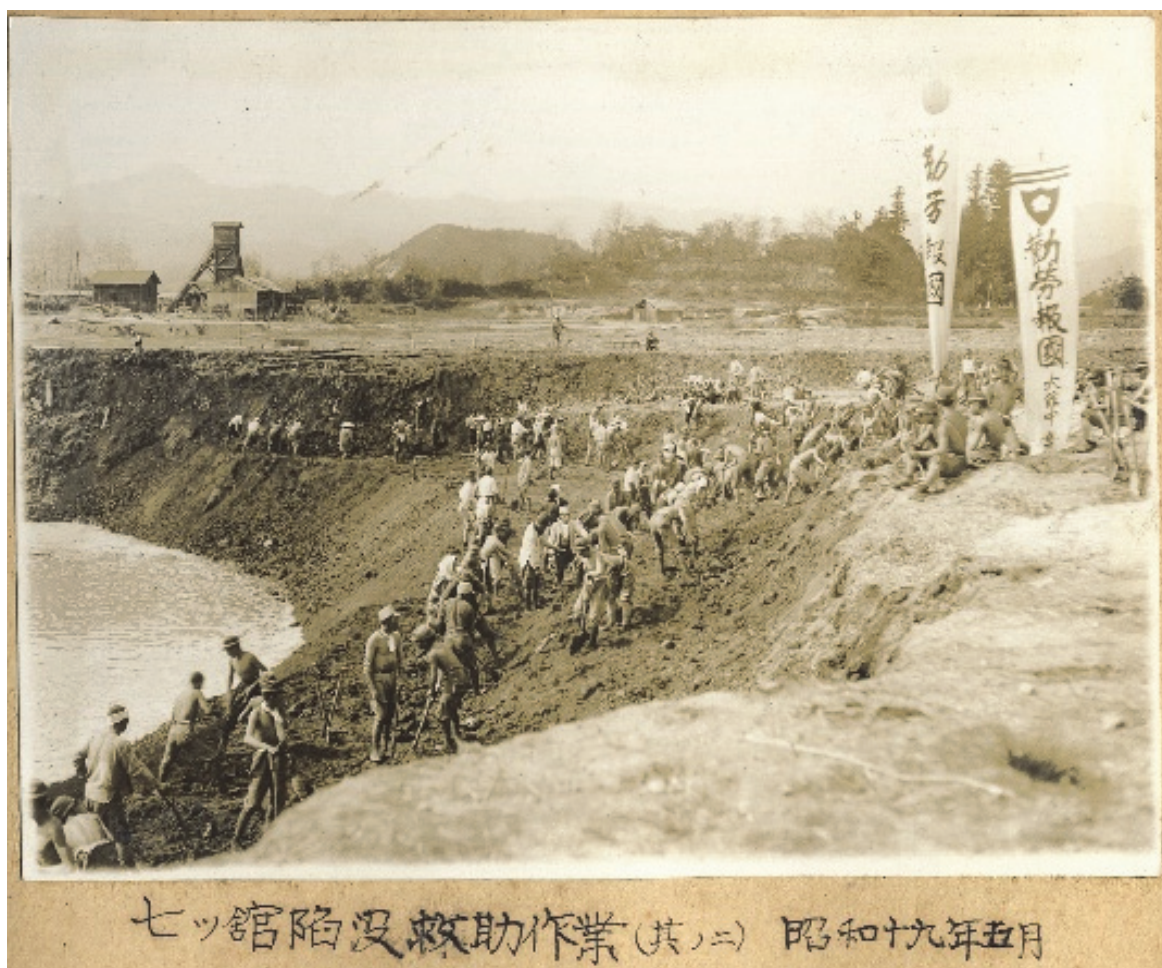
図 2 七ツ館陥没救助作業 (其ノ二 昭和十九年五月) (大館郷土博物館収蔵資料)
