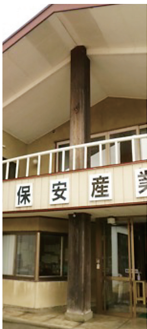
図13 会館正面の通し柱
