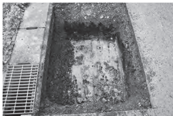
T P - 17 (北東から)
