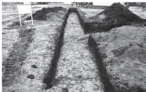
完掘状況 (南から)
