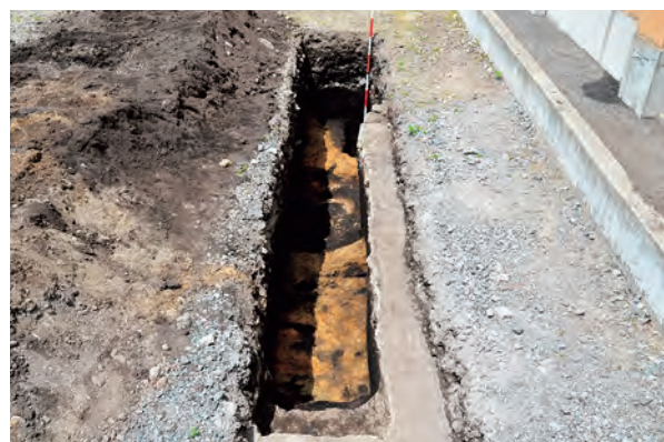
トレンチ 3 調査状況
