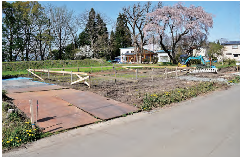
近景（南西から）
