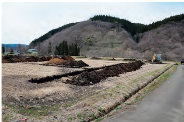
調査区近景（南東から）
