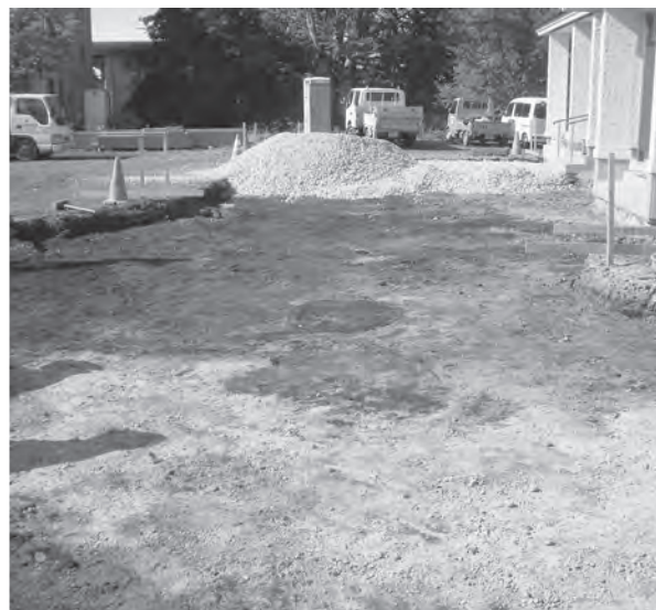
工事立会の状況（ロードヒーティング部分）
