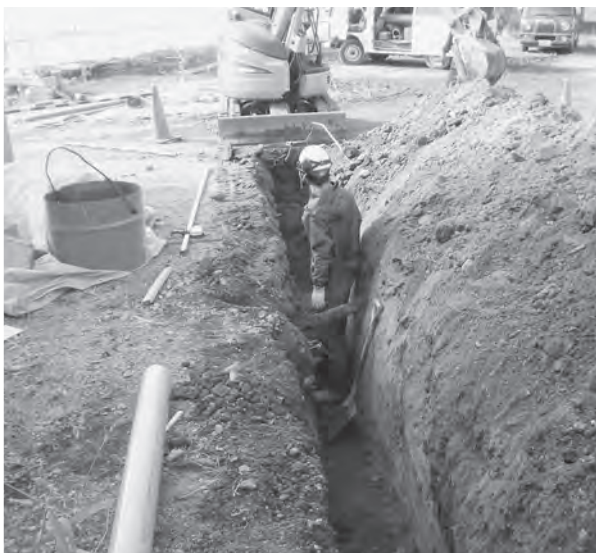
工事立会の状況（水道工事）
