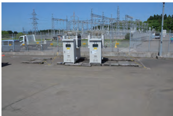
調査地区近景
