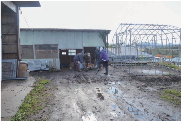
浄化槽設置部分調査地全景
