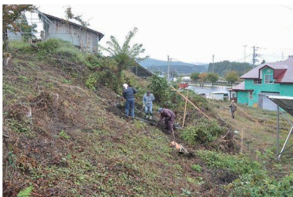
作業状況（西から）
