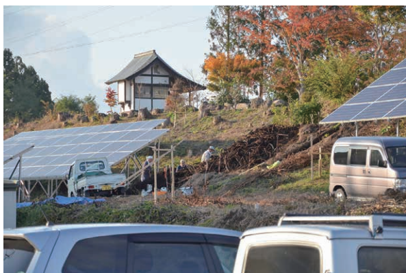
私道部分調査地全景（南東から）
