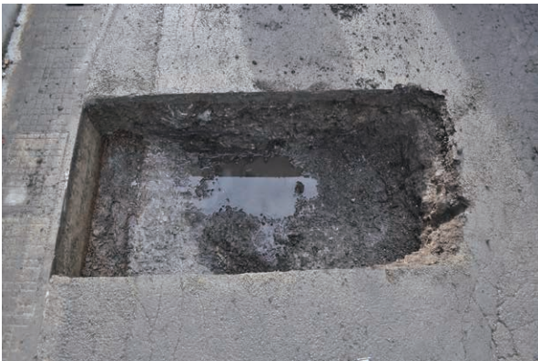
3 調査状況（北から）
