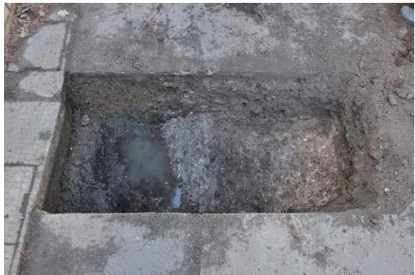
4 調査状況（北から）
