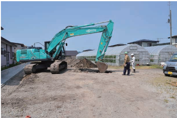
重機による掘削
