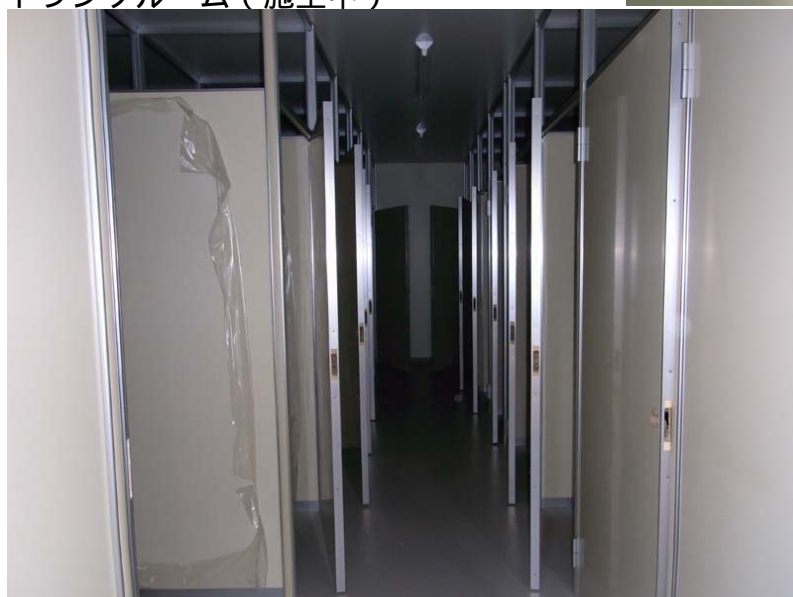
トランクルーム (施工中)
