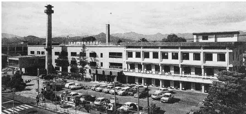
市役所本庁舎増築工事完成
