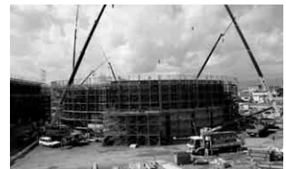
建設中の校舎
