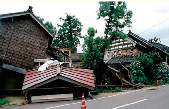
木造建物被害の例（平成19年7月新潟県中越沖地震）
