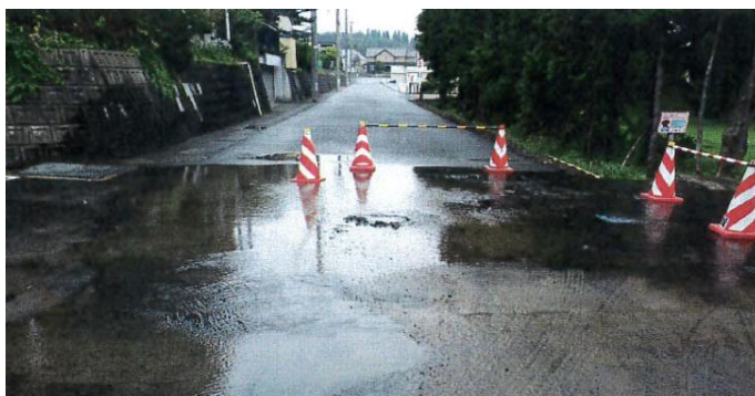
令和元年9月 岩瀬地区漏水緊急修繕
