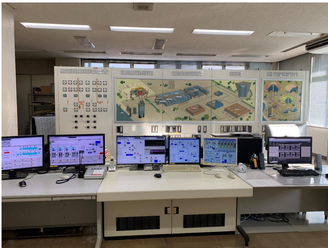
中央管理室 (山館浄水場管理本館)
