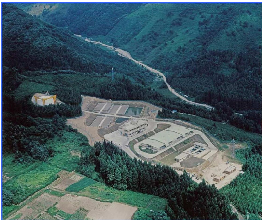
山館浄水場（S 52 年建設当時）
