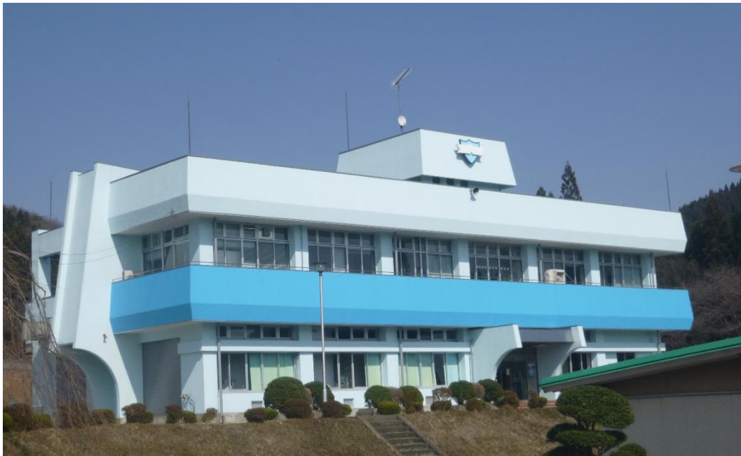
現在の山館浄水場管理棟
