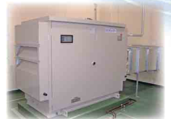
【災害対策】 矢立浄水場の 非常用発電機
