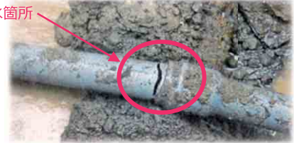
漏水の原因となる管の破断（塩ビ管）
