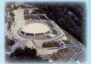
建設当時の長根山配水池
