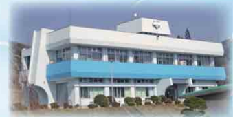
山館浄水場管理棟
