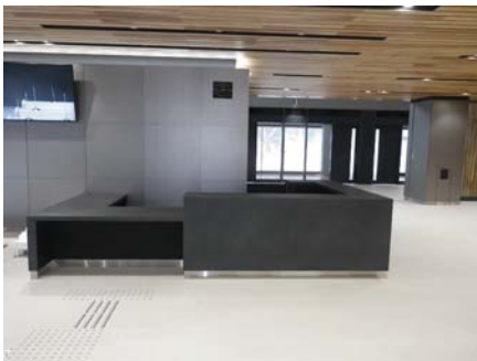
〈窓口まで障害者誘導用ブロックの設置〉
