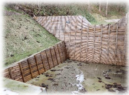
治山ダム（木製型枠）
