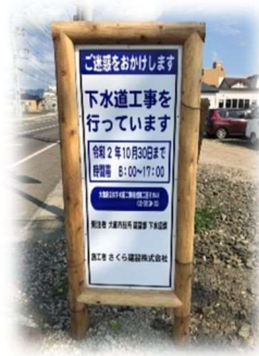
工事中看板 (間伐材)
