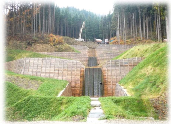
治山ダム（木製型枠）
