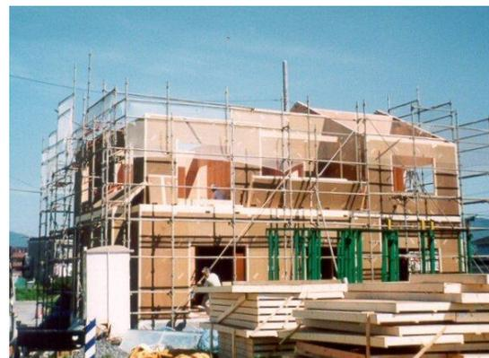
写真2 建設中のプレハブパネル工法住宅とパネル(手前)
