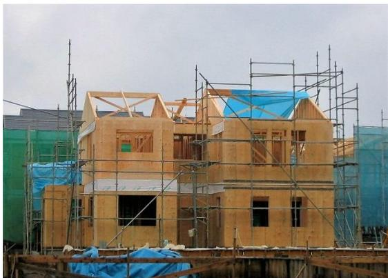
写真1 建設中の枠組壁工法住宅
