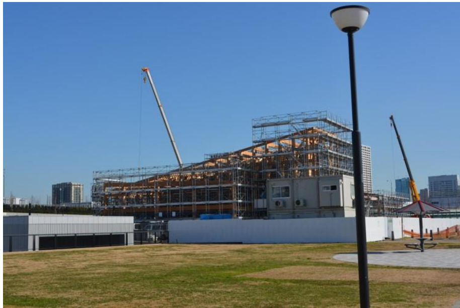
建設中 (2020年1月30日撮影)
