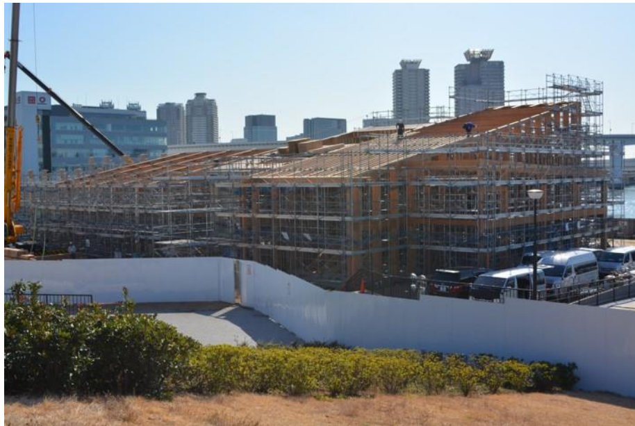
建設中 (2020年1月30日撮影)
