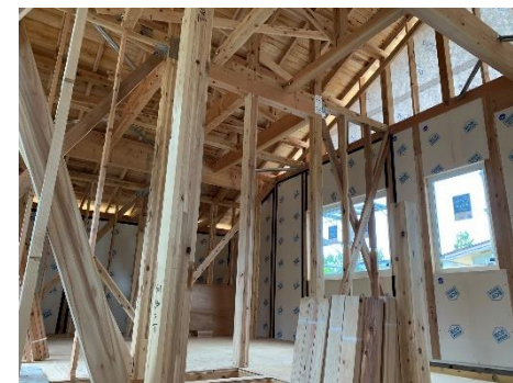
写真5 在来軸組工法
