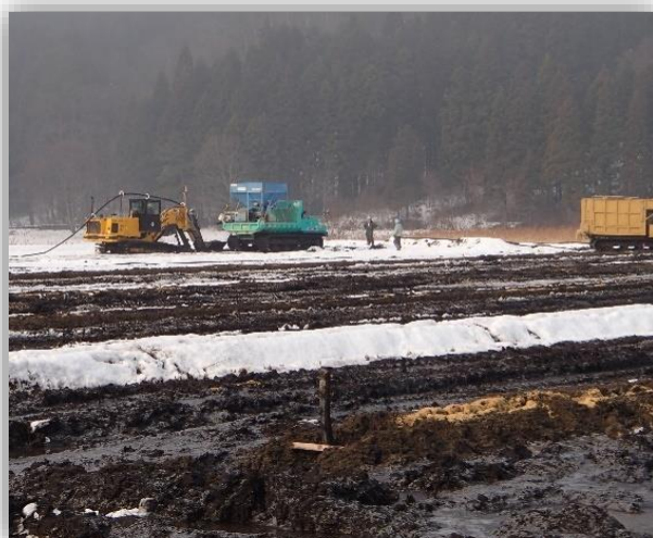
ほ場整備工事の作業風景
