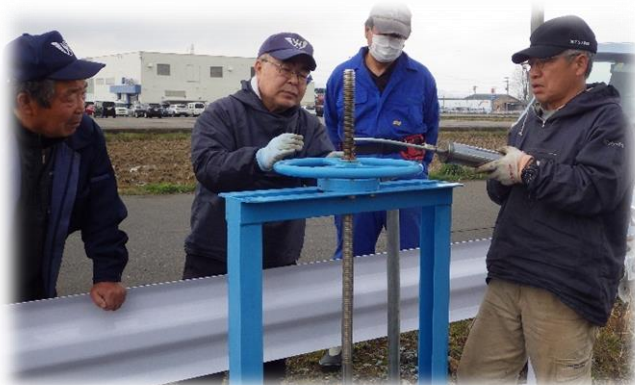
農業水利施設の点検パトロール
