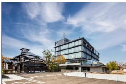
大館市役所本庁舎 外観
