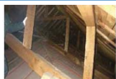
覆屋根(小屋裏状況)
