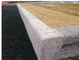
②景観型縁石、③側溝改良 側溝の傷み大きい交換(地元要望)
