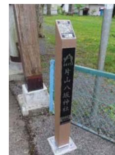
片山八坂神社(平成29年度設置) 木材・プラスチック再生複合材 120mm×120mm×高さ1,200mm
