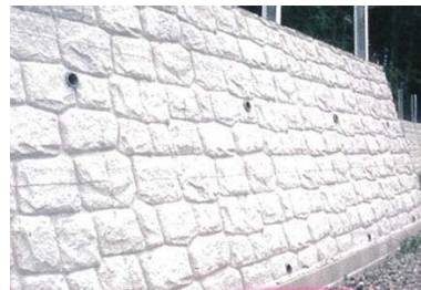
化粧型枠を使用した表面仕上げ
