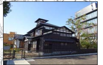
桜櫓館（耐震改修工事完成） 令和3年4月から公開・貸館を再開
