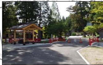
大館神明社（手水舎改修・曳山車通路完成）
