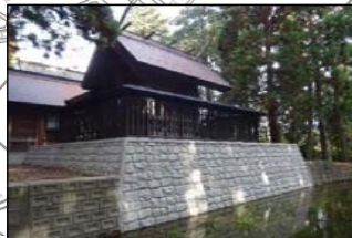
大館神明社（本殿玉垣改修完成）
