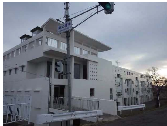
改修を行った水門前住宅
