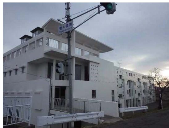
改修を行った水門前住宅
