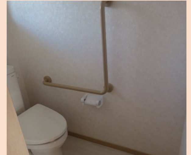
整備例：手すりの設置 【高齢者等配慮対策等級3】(市営大森野住宅)
