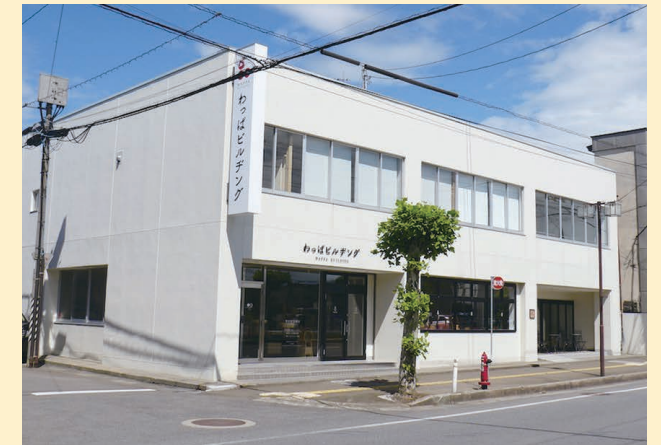
民間によるリノベーション事例 「わっぱビルディング」
