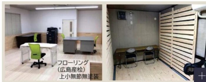
一場木工所と広島大学大学院人間社会科学研究科が実施した内装木質化の様子。左の写真は木質化後の関係会社のオフィスビルの一室。右の写真はプレハブ式現場事務所を仮設の木質パネルで木質化した様子（出所：日本住宅・木材技術センター「内装木質化等の効果実証事業 成果報告会」資料、特記以外は以下同）
